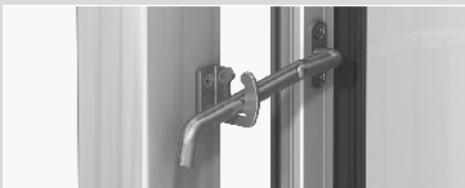
► **Der PN-Sicherungsbeschlag** sichert zusätzlich gegen ein Eindringen von außen, wenn das Fenster geöffnet ist. Um das Fenster zu öffnen, muss der Hebel angehoben werden. Nur wenn der Hebel in vertikale Position gebracht wurde, lässt sich das Fenster komplett öffnen.
